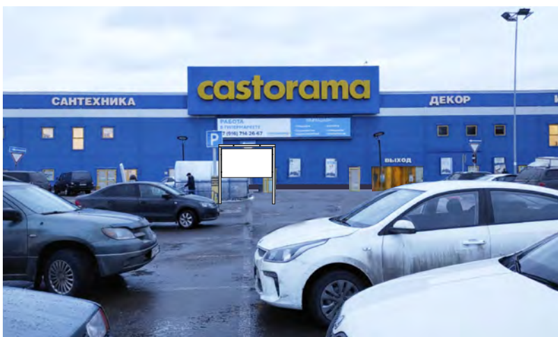
434. г. Щёлково, Пролетарский пр-кт, д.20, щит о/с, внутренний подсвет, 3,5 x 3,7 м, сторона А
